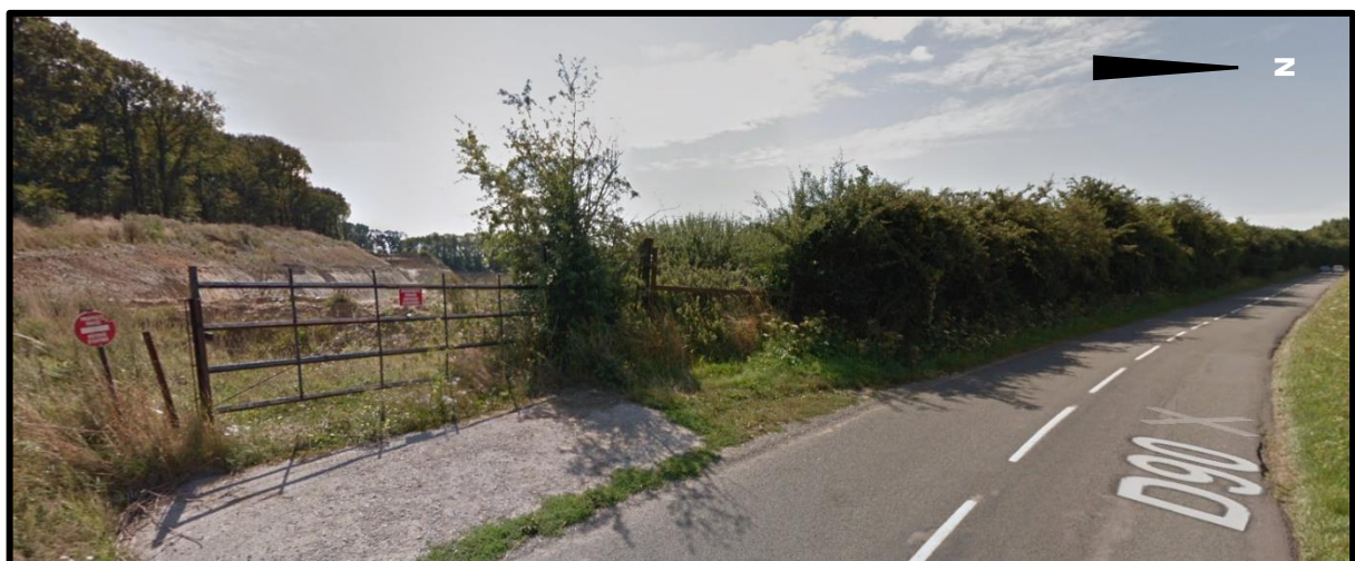
Figure 61 : Point de Vue 3 : Vue depuis la RD90, en bordure de la carrière : La haie arbustive masque la carrière
